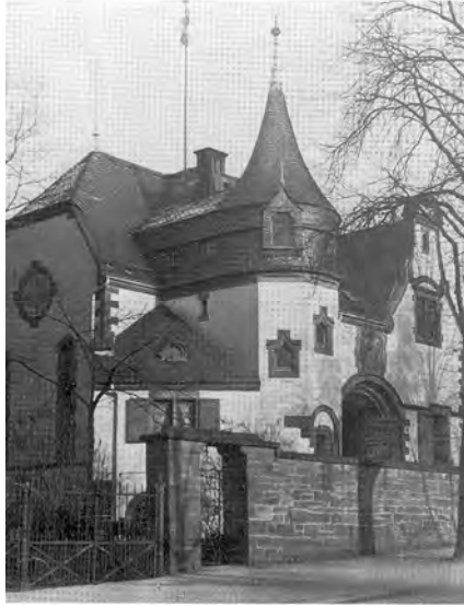
Zerstörtes Corpshaus Teutonia Gießen in der Kaiserallee 81 (jetzt Grünbergstraße) (Abbildung 6)
