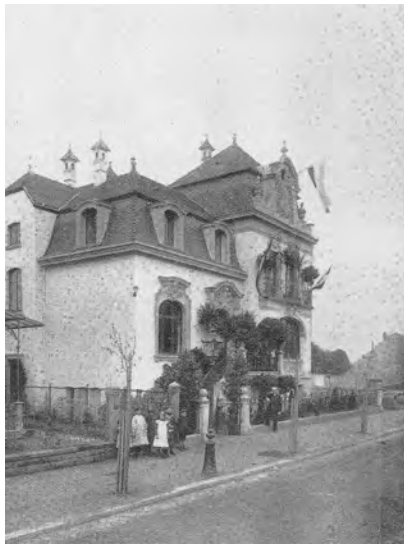
Corpshaus Rhenania in Straßburg in der Lessingstraße (Abbildung 23)
