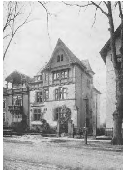
Corpshaus Rhenania-Straßburg in Marburg in der Schwanallee 43 (Abbildung 24)
