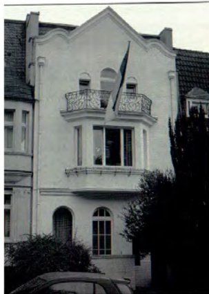
Corpshauses in der Nizzaallee 63 in Aachen (Abbildung 32a)
