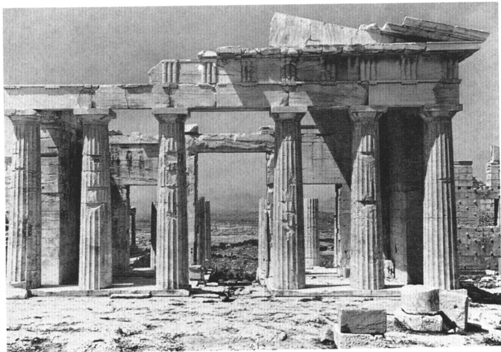
Abb. 6 Propyläen. Burgseitige Fassade des Mitteltrakts.
