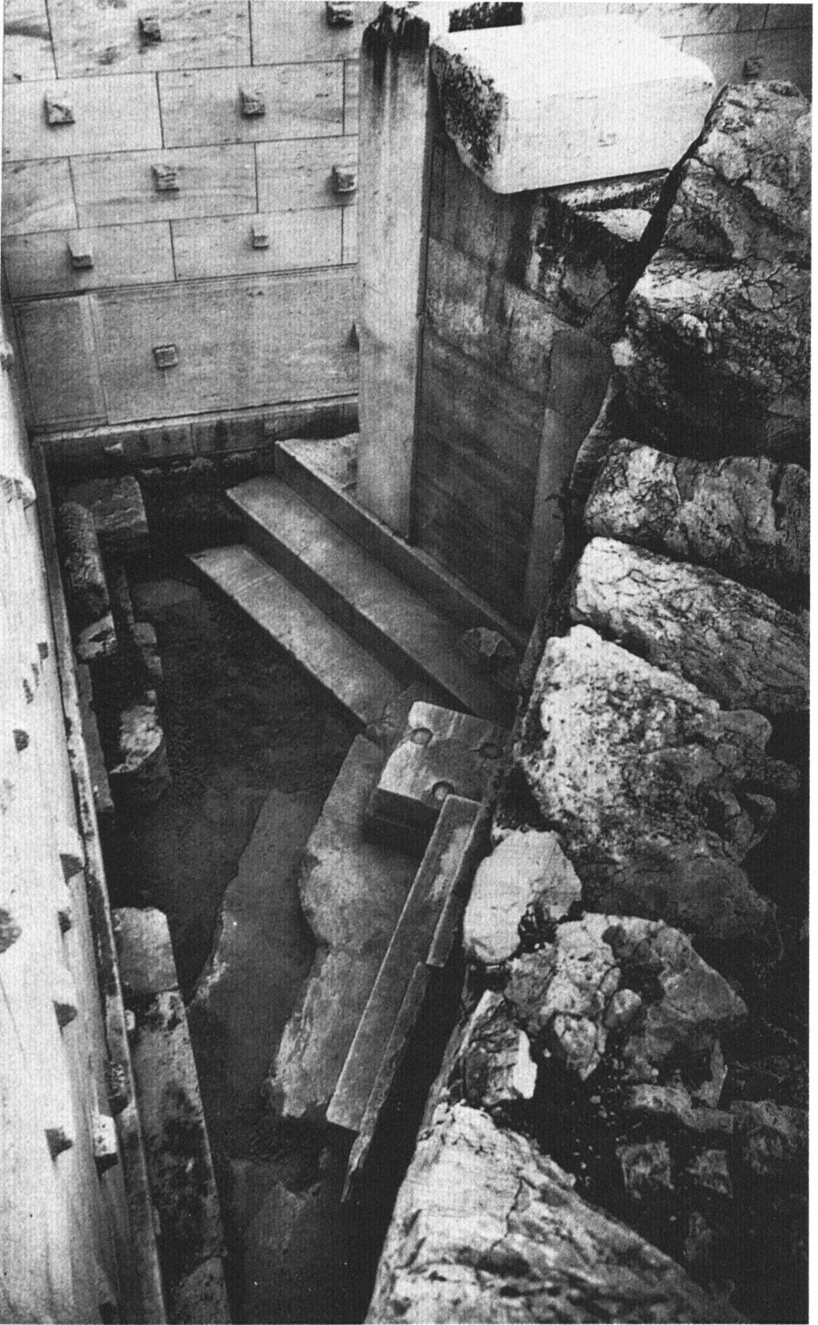
Abb. 31 Erhaltene Reste des alten Propylon.
