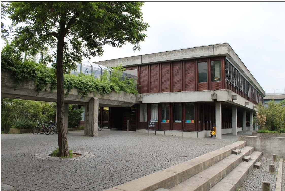
Abbildung 2: Rechenzentrum Haupteingang des EG
