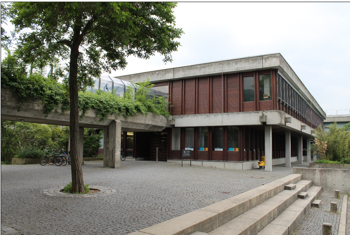
Abbildung 2: Rechenzentrum Haupteingang des EG
