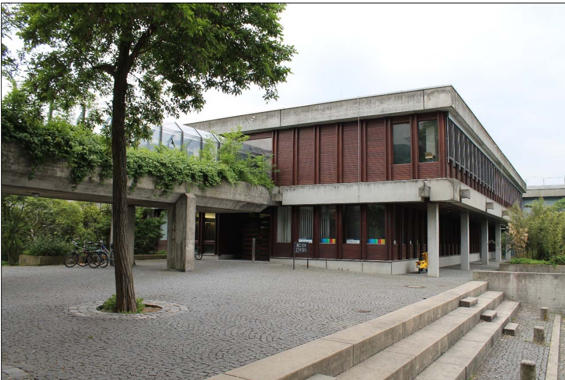
Abbildung 2: Rechenzentrum Haupteingang des EG
