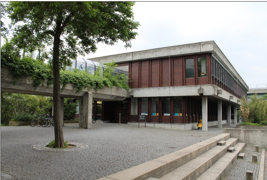
Abbildung 2: Rechenzentrum Haupteingang des EG
