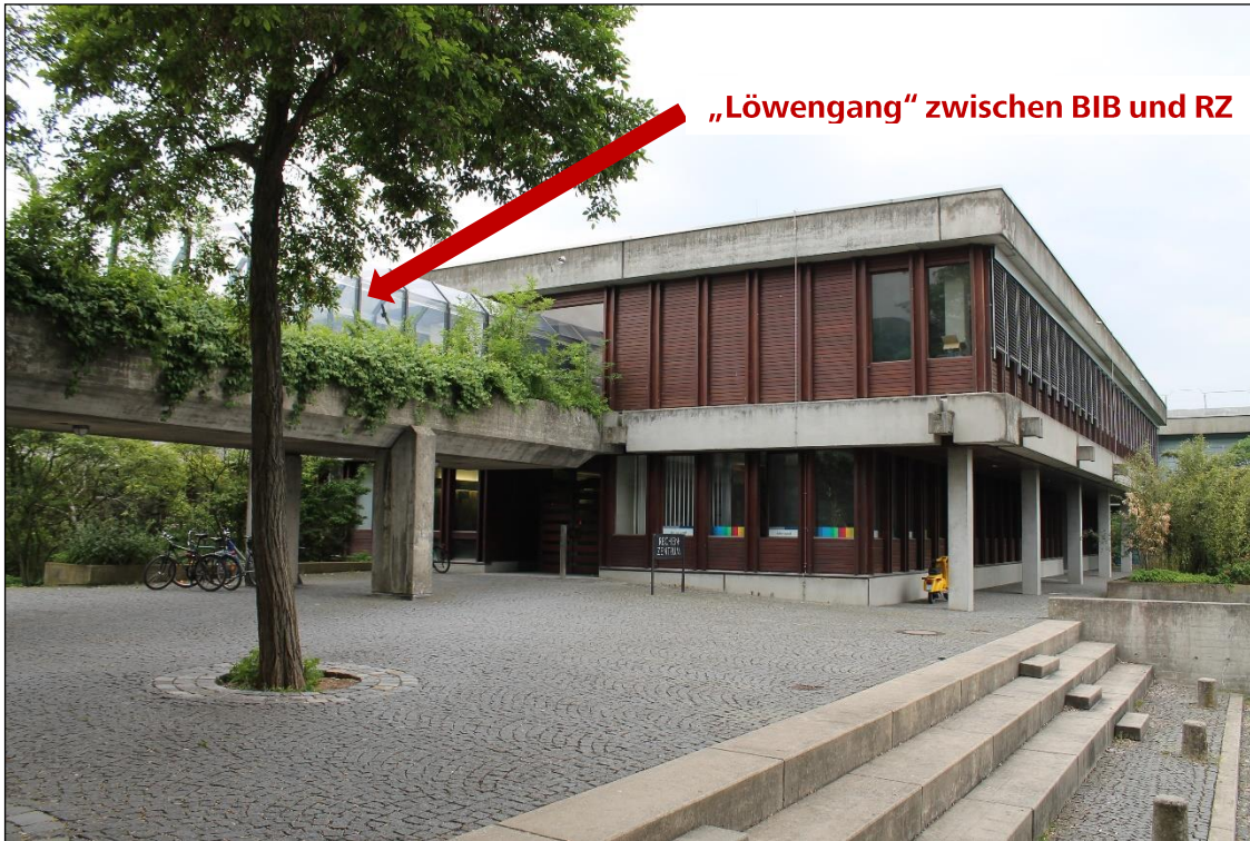
Abbildung 2: Rechenzentrum Haupteingang des EG
