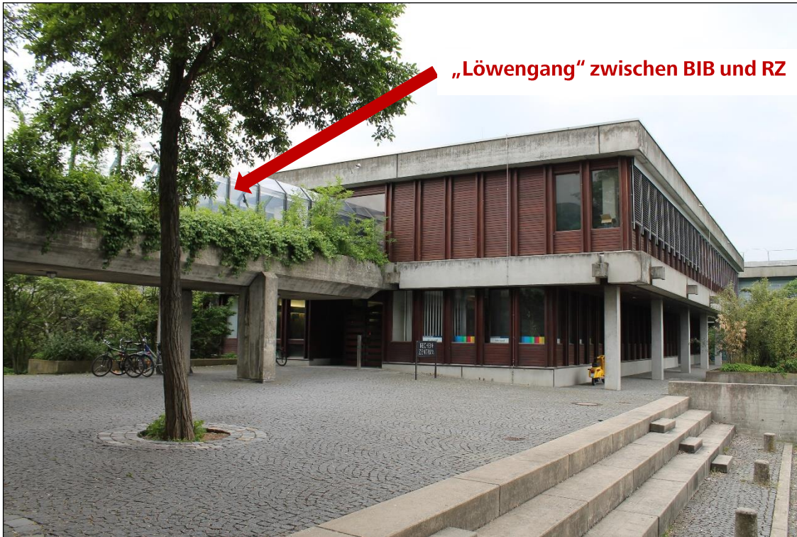
Abbildung 2: Rechenzentrum Haupteingang des EG
