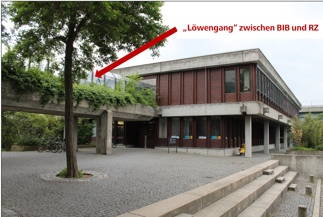
Abbildung 2: Rechenzentrum Haupteingang des EG
