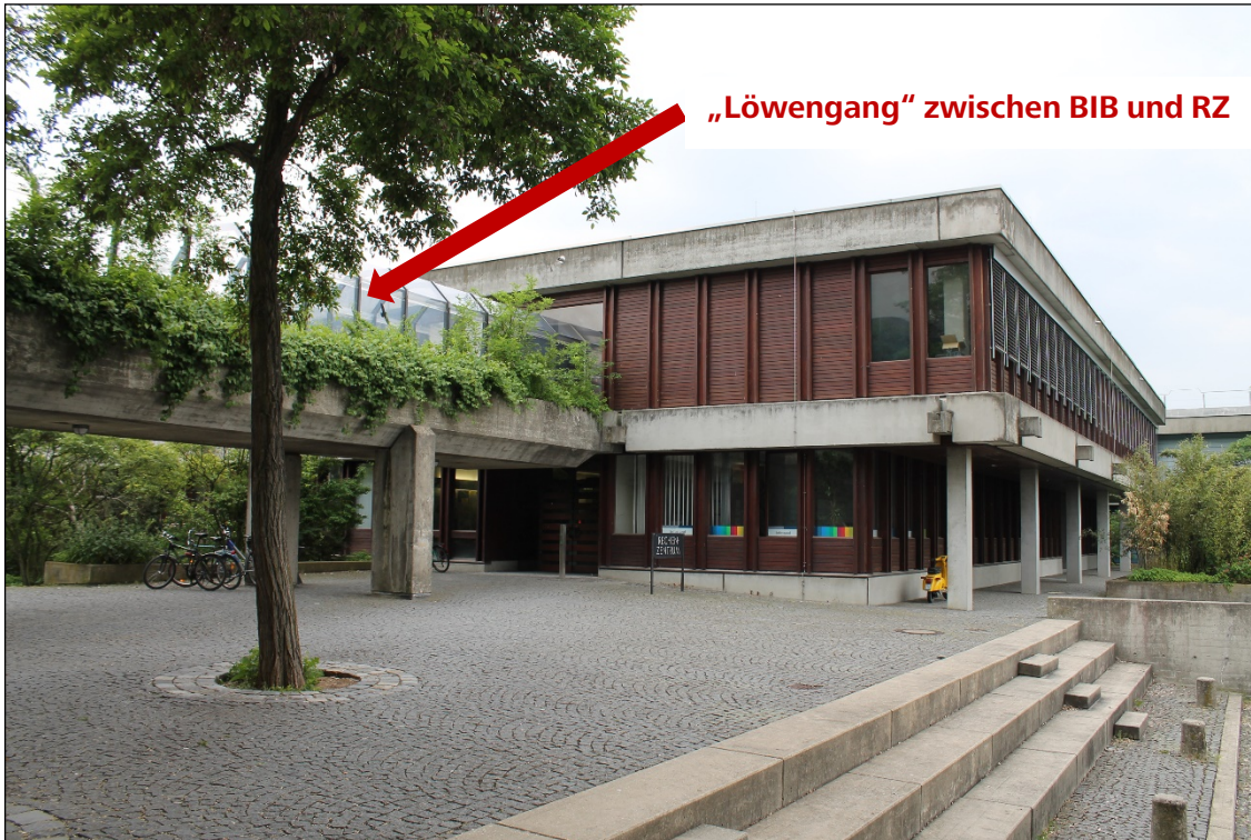
Abbildung 2: Rechenzentrum Haupteingang des EG
