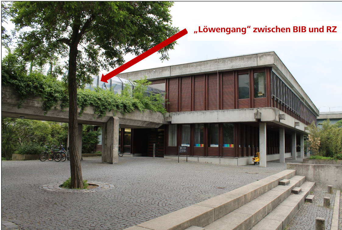
Abbildung 2: Rechenzentrum Haupteingang des EG
