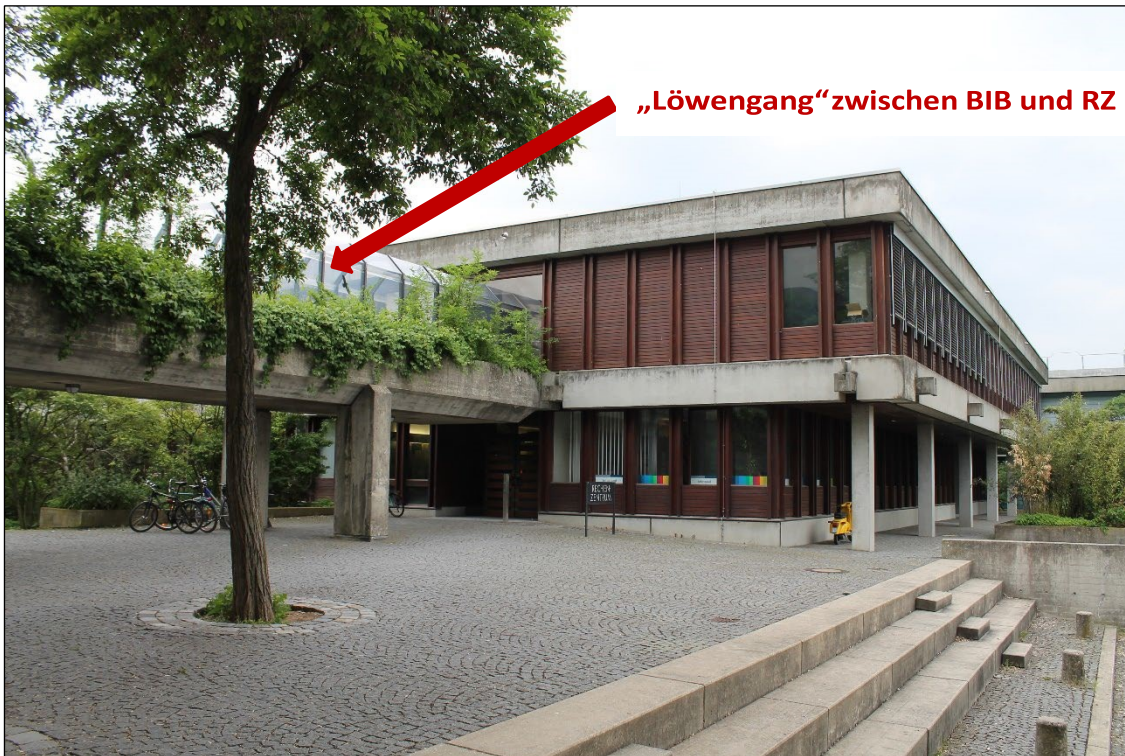
Abbildung 2: Rechenzentrum Haupteingang des EG
