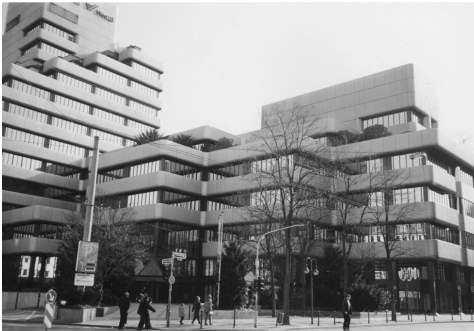
Abbildung 20: Komplexes Bürogebäude (WestLB, Friedrichstadt)
