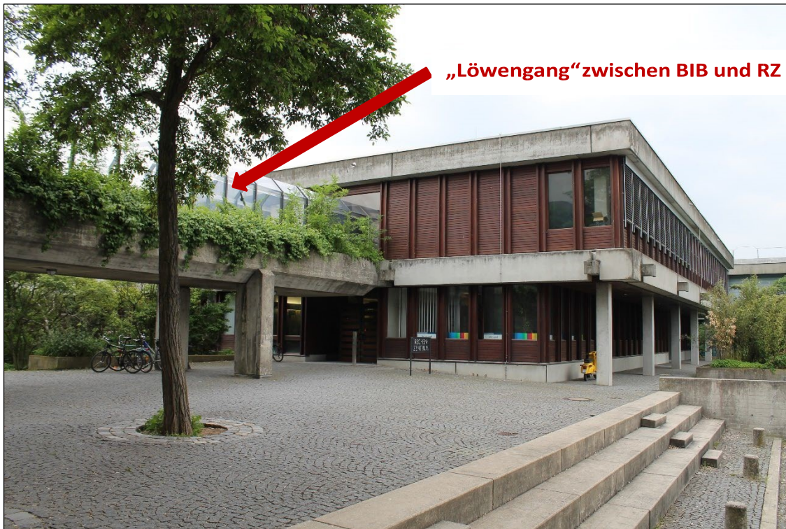
Abbildung 2: Rechenzentrum Haupteingang des EG
