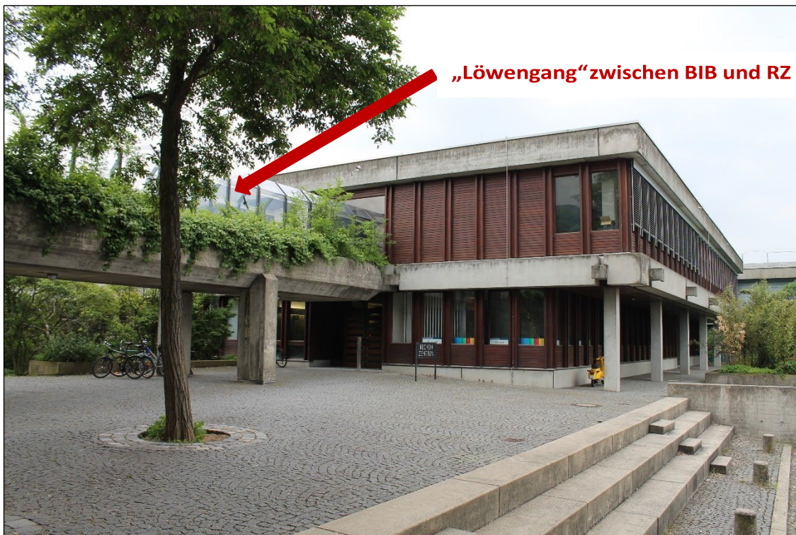
Abbildung 2: Rechenzentrum Haupteingang des EG
